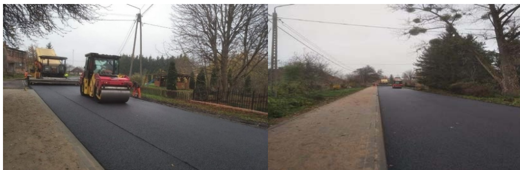
Remont drogi na odcinku Barciszewo – Wojciechy oraz w Taplikajmach
