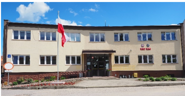
Budynek Urzędu Gminy
