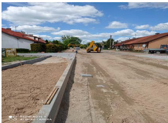
Droga w Płesach podczas remontu
