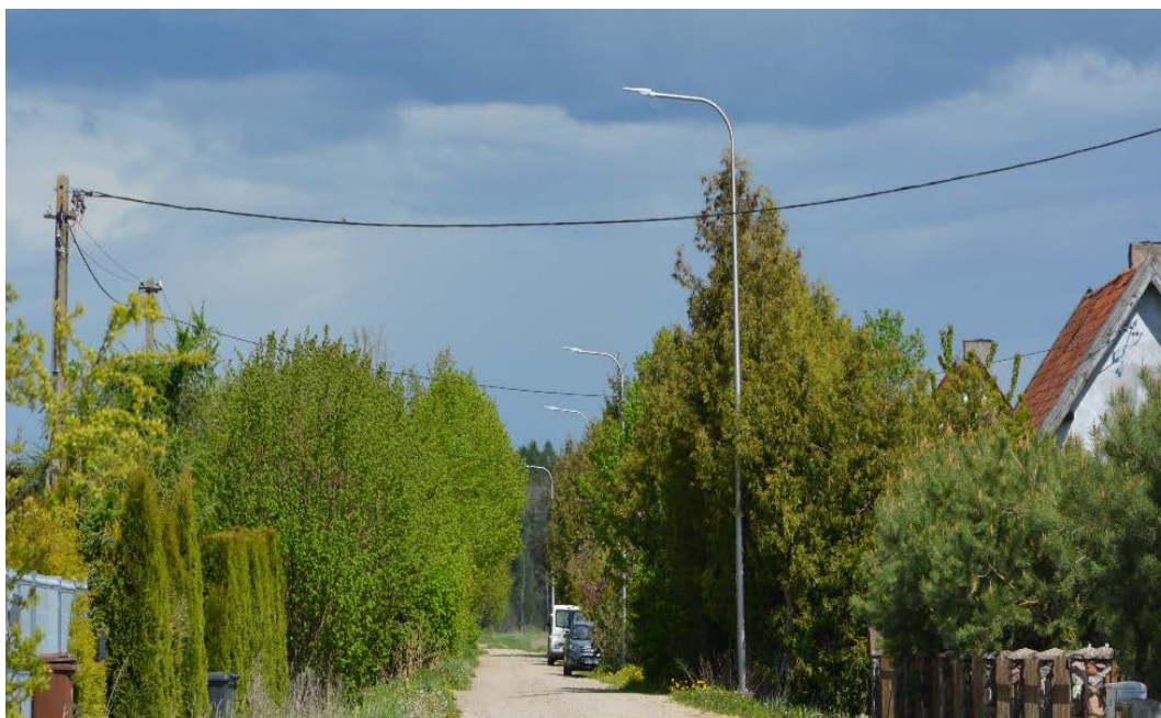
Nowo powstałe oświetlenie w Dąbrowie/Kolonia
