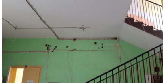
Budynek podczas remontu
