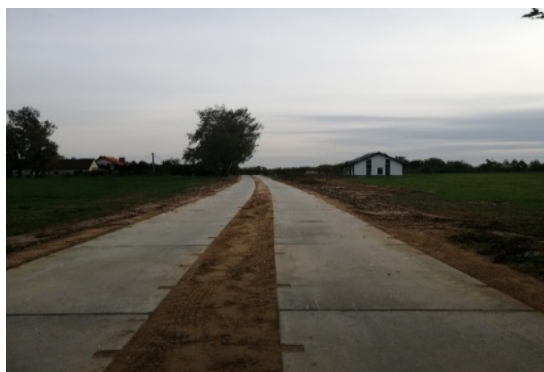
Droga w Szwarunach po remoncie
