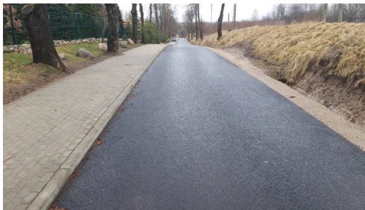
Droga w Połęczu po remoncie
