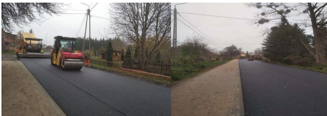
Remont drogi na odcinku Barciszewo – Wojciechy oraz w Taplikajmach
