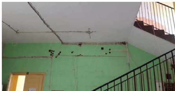
Budynek podczas remontu
