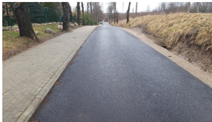
Droga w Połęczu po remoncie
