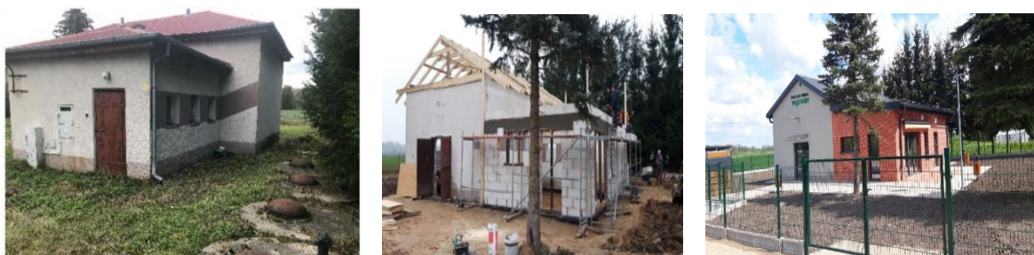
Budynek przed, w trakcie i po remoncie
