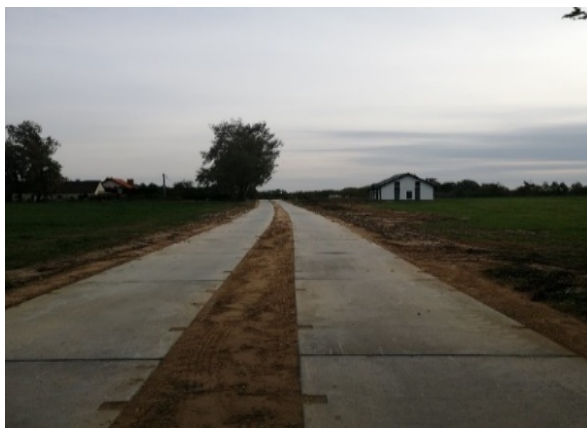
Droga w Szwarunach po remoncie
