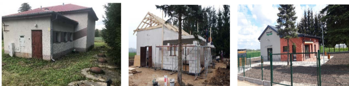
Budynek przed, w trakcie i po remoncie
