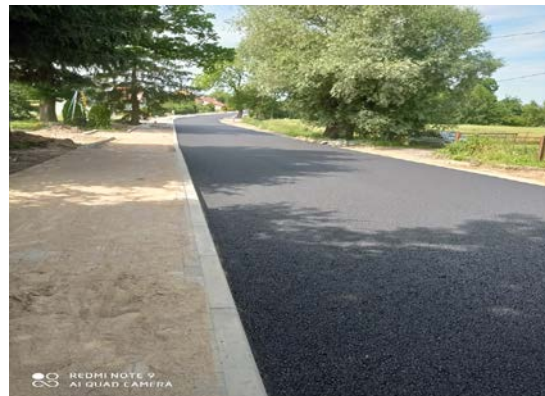
Droga w Płesach po remoncie
