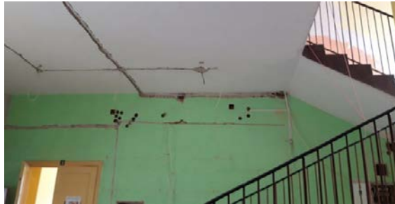
Budynek podczas remontu
