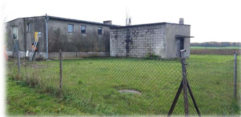
Budynek SUW przed rozpoczęciem remontu
