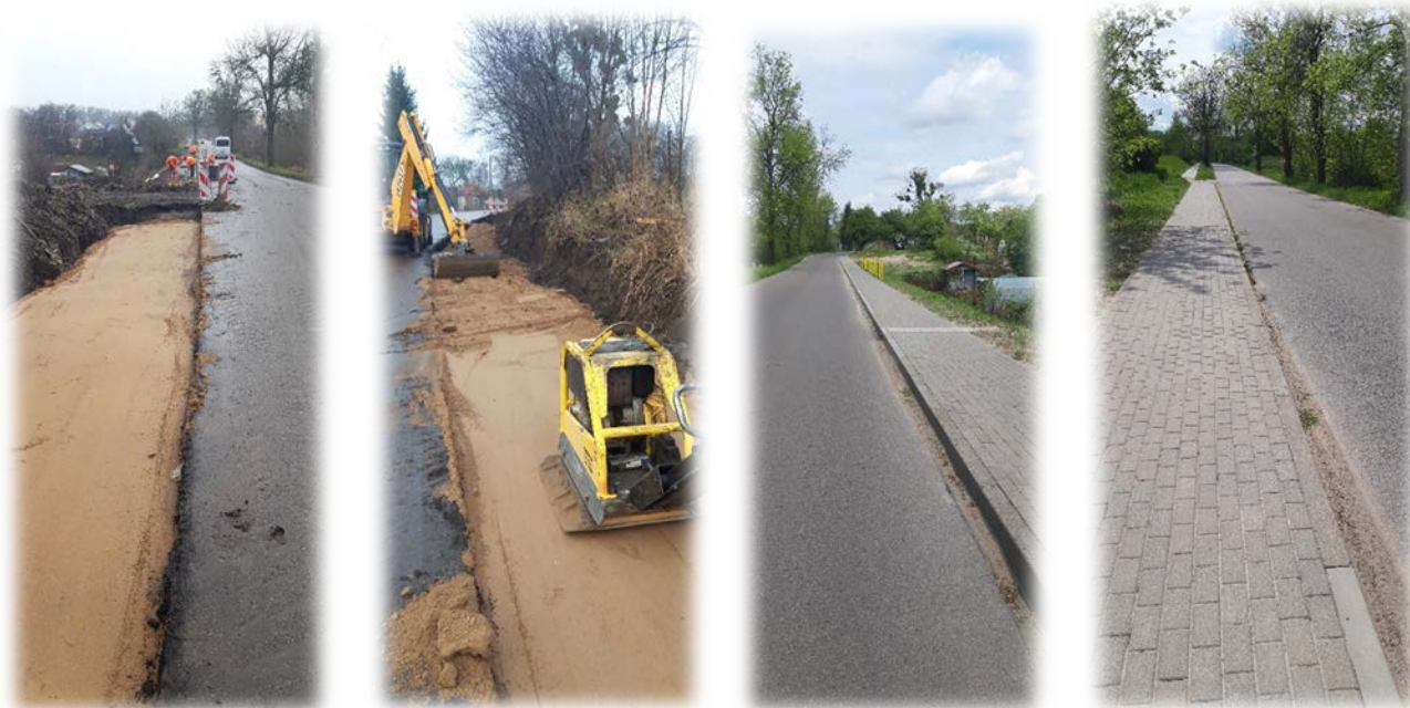
Budowa chodnika w trakcie i po zakończeniu budowy
