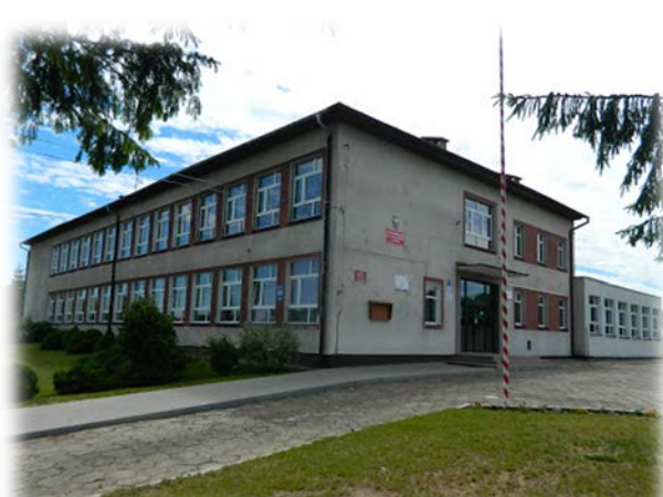
Budynek szkoły przed remontem
