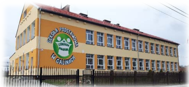
Szkola Podstawowa w Galinach po kompleksowej termomodernizacji
