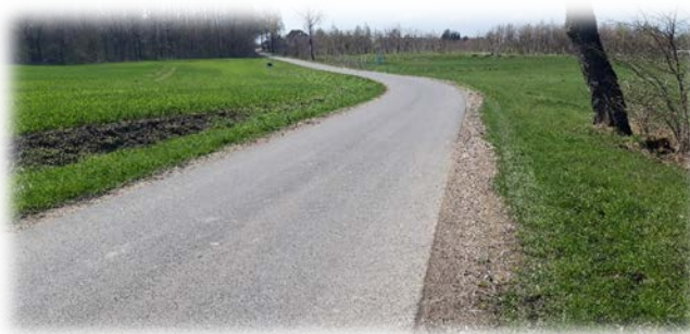
Wyremontowana droga gminna w Łojdach
