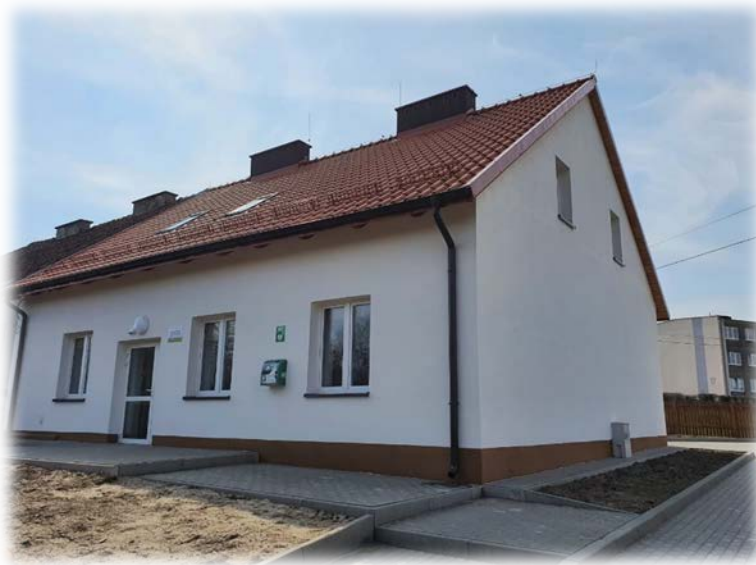
Budynek po remoncie
