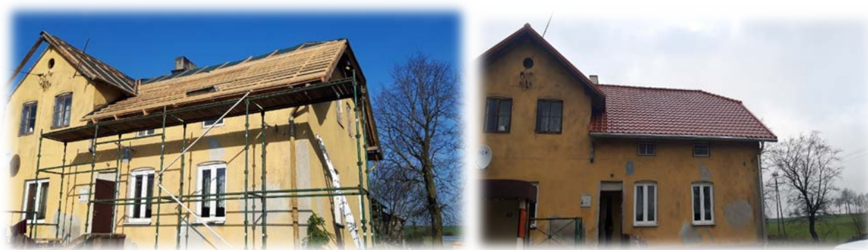
Wymienione pokrycie dachowe – Budynek świetlicy wiejskiej w Kiersitach przed i po remoncie
