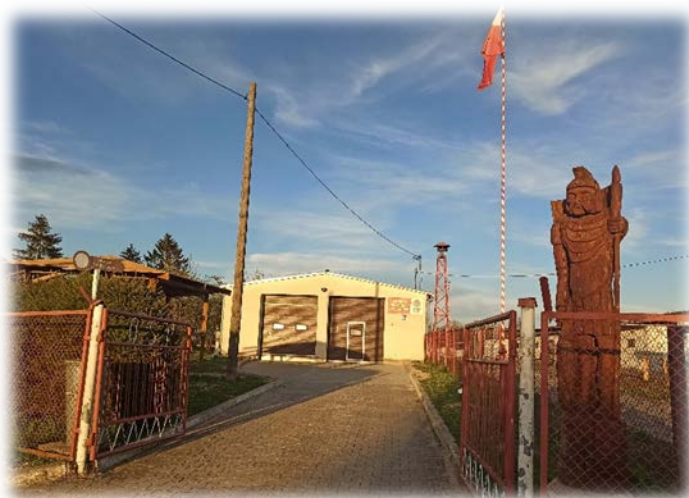
Budynek OSP w Wojciechach wykonany podjazd z kostki brukowej
