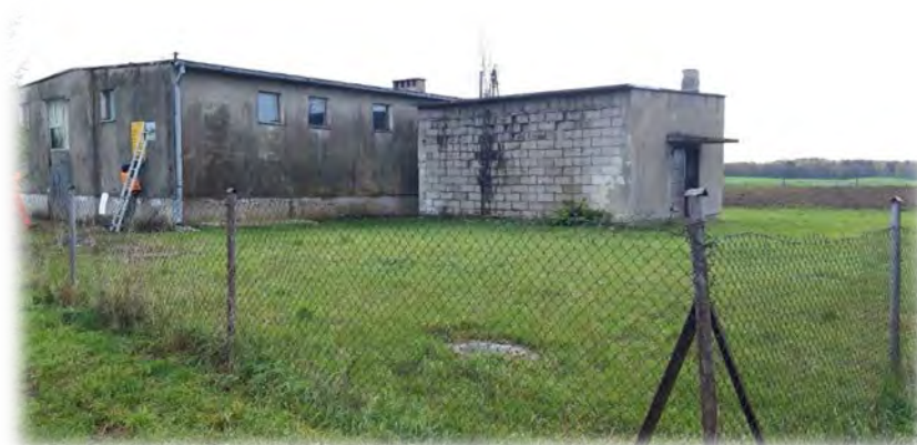
Budynek SUW przed rozpoczęciem remontu
