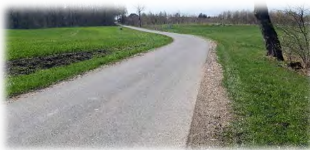
Wyremontowana droga gminna w Łojdach
