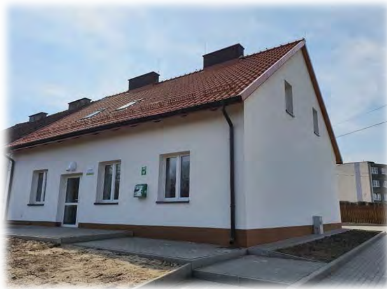
Budynek po remoncie
