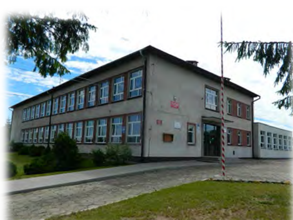
Budynek szkoły przed remontem
