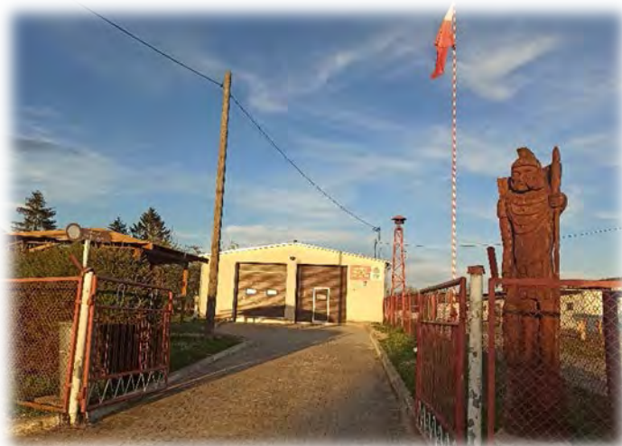
Budynek OSP w Wojciechach wykonany podjazd z kostki brukowej
