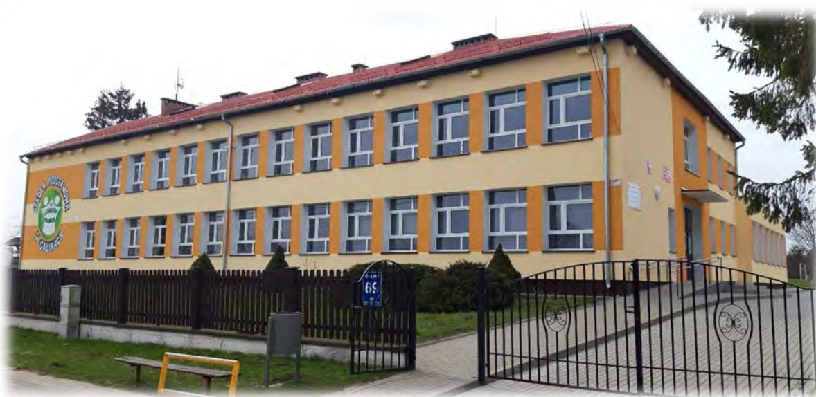
Budynek szkoły po remoncie
