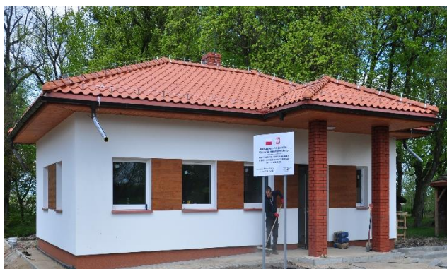
Budynek świetlicy w Maszewach w trakcie budowy
