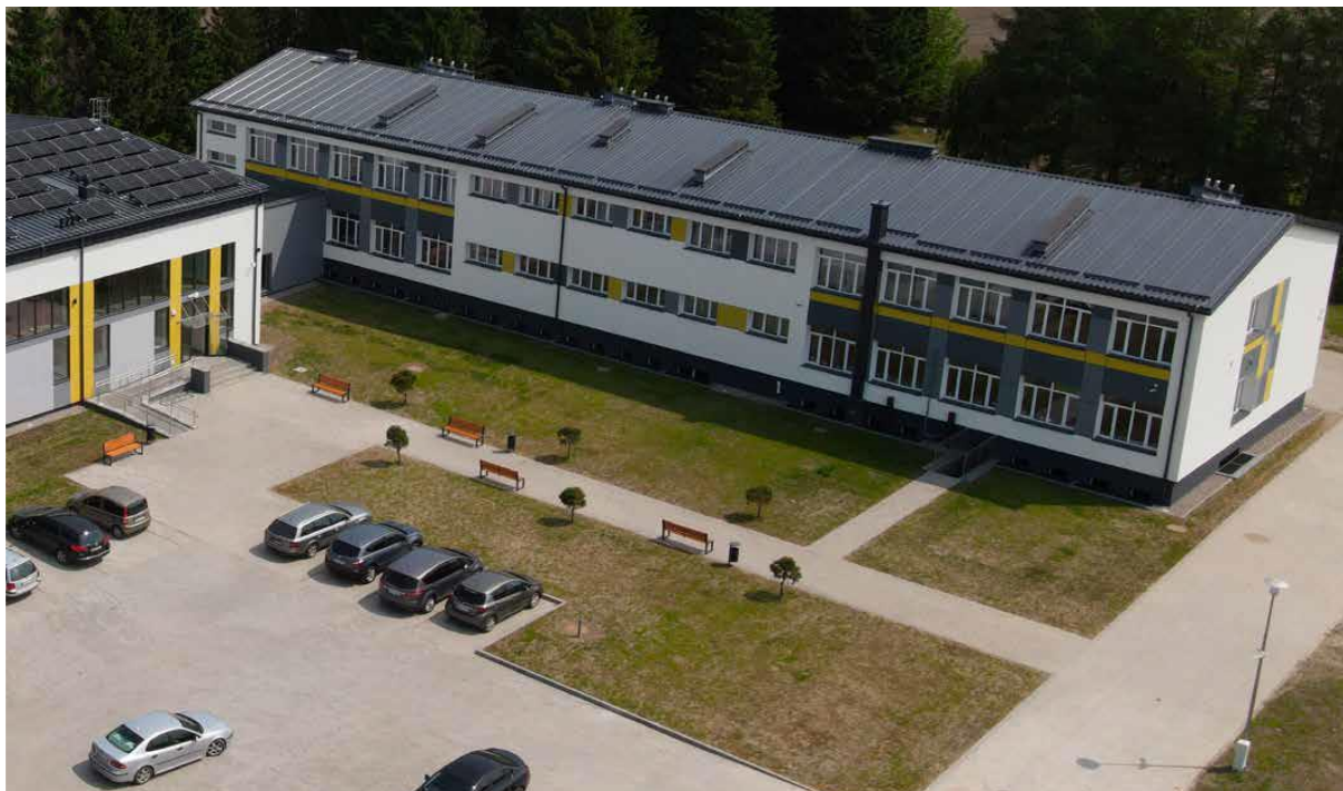
Budynek dydaktyczny po termomodernizacji oraz parking i drogi dojazdowe do sali sportowej SP w Kinkajmach
