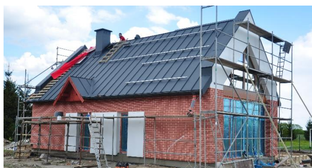
Budynek świetlicy w Spytajnach w trakcie budowy
