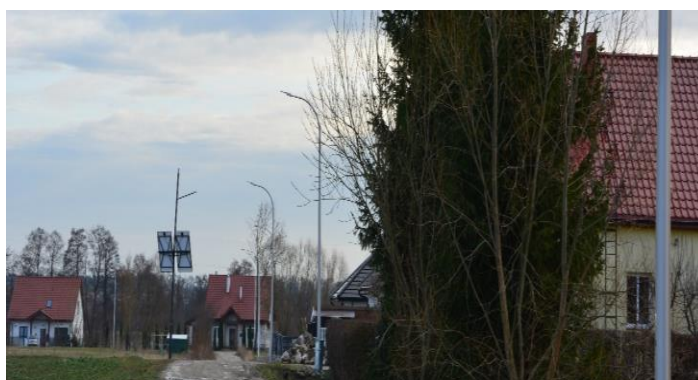
Rozbudowa oświetlenia w Dąbrowie
