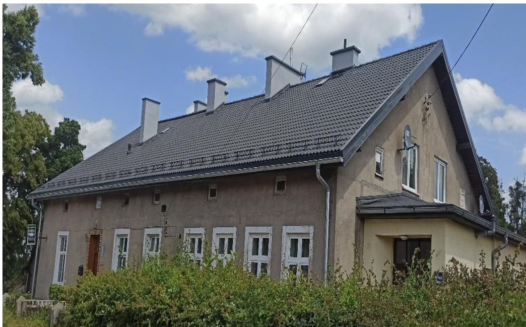
Wymiana pokrycia dachowego na budynku świetlicy wiejskiej w Krawczykach
