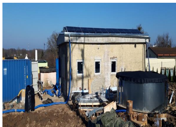
SUW w Galinach w trakcie przebudowy
