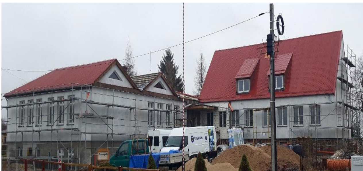
Dom Pomocy Społecznej w Sokolicy w trakcie budowy
