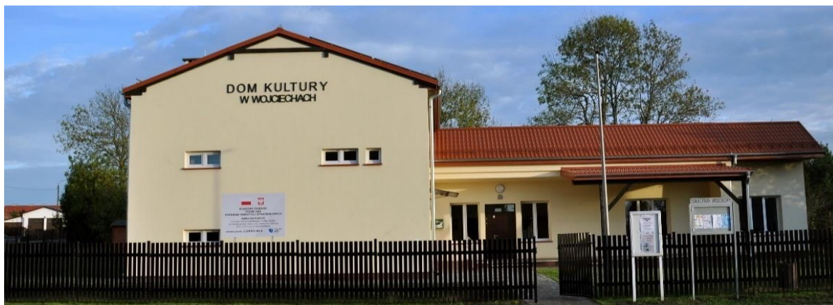
Budynek Domu Kultury w Wojciechach po remoncie
