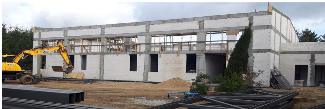
Budynek sali sportowej w trakcie budowy
