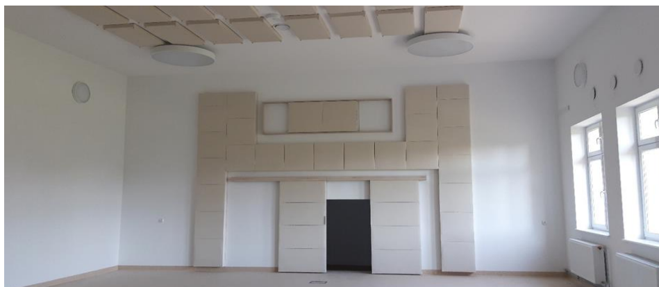
Sala główna w Domu Kultury w Wojciechach po remoncie
