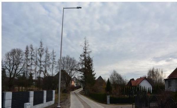
Rozbudowa oświetlenia w Galinach
