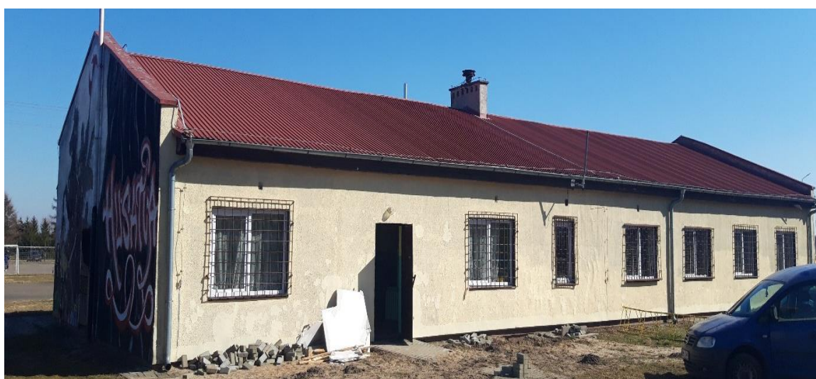
Budynek kultury fizycznej w Kinkajmach przed modernizacją i przekształceniem na remizę
