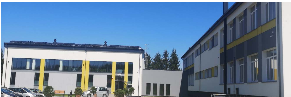
Nowa sala sportowa wraz z łącznikiem
