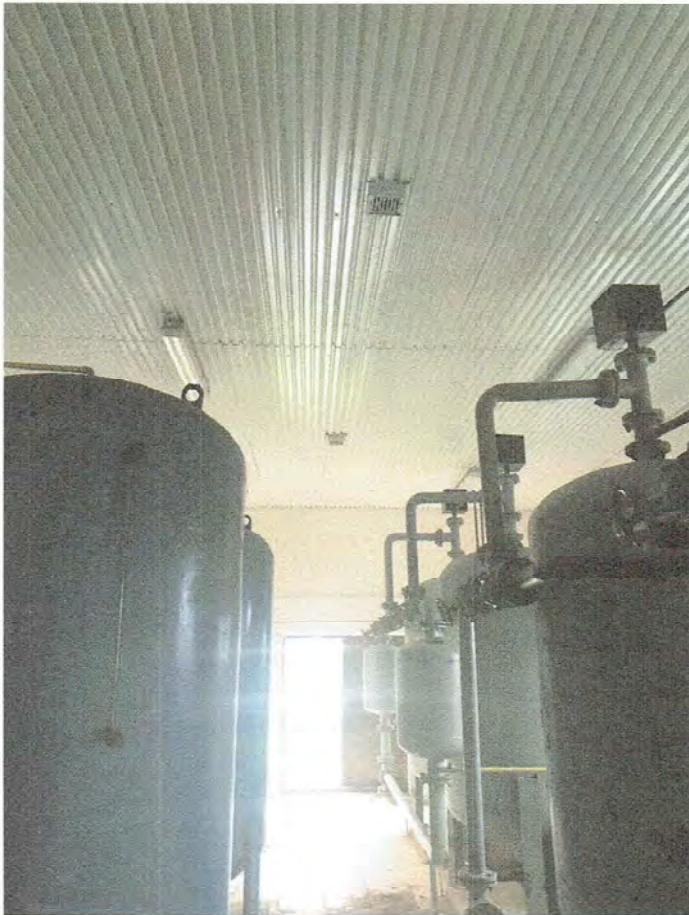
zbiorniki do rozbiórki
