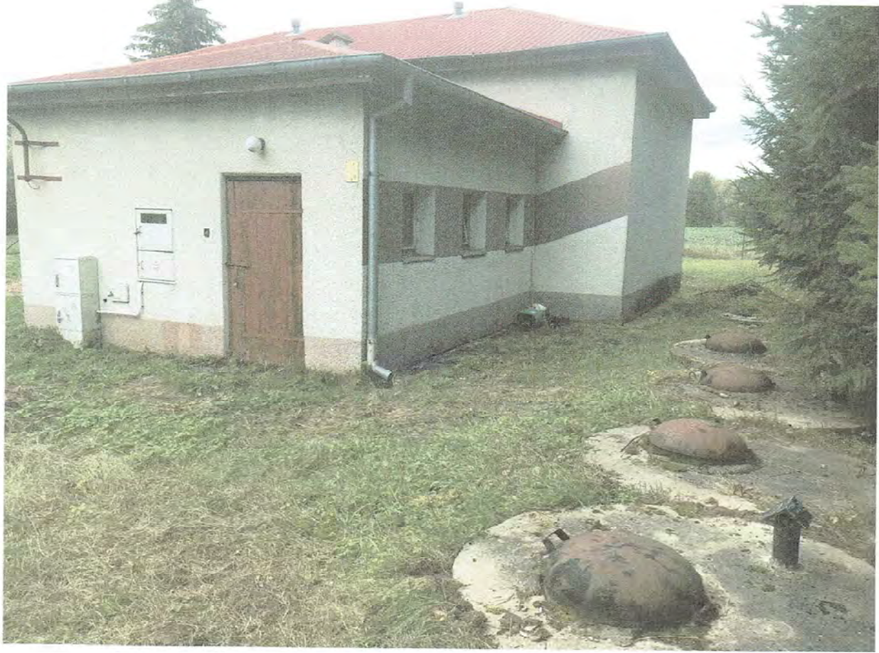
Elewacja południowa wejście do zaplecza i elewacja wschodnia
