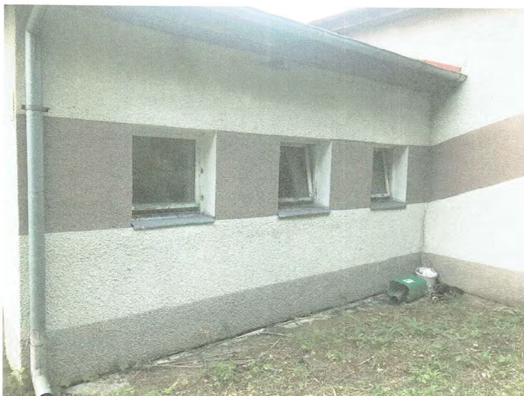
Elewacja wschodnia - zaplecze
