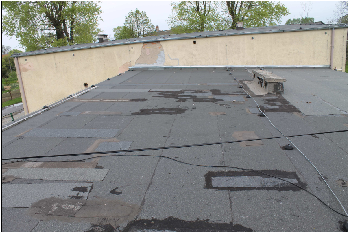
Fot. nr 3. Widok połaci dachowej budynku.
