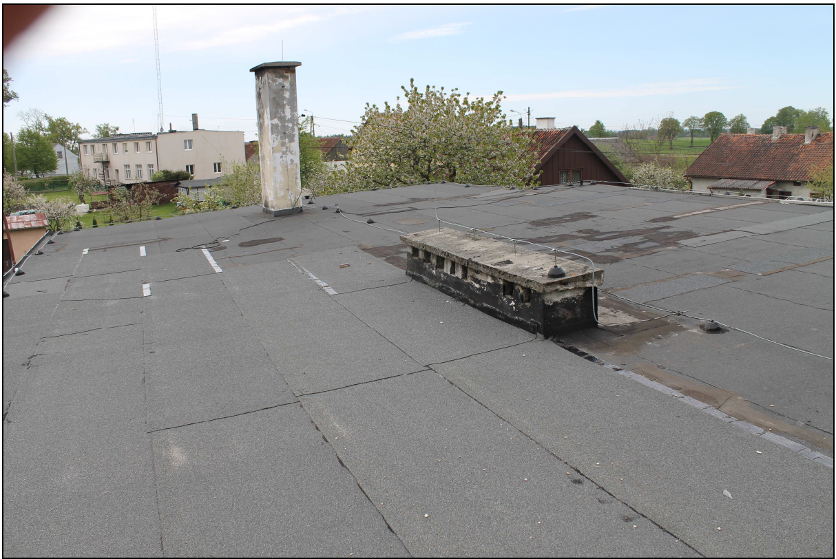
Fot. nr 2. Widok pokrycia dachu ponad niższą częścią budynku.
